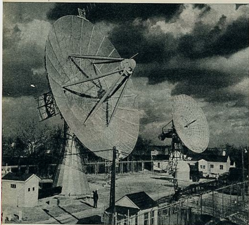
Sistema de antenas instalado en Fort Monmouth para enviar y recibir fotografías del satélite.
