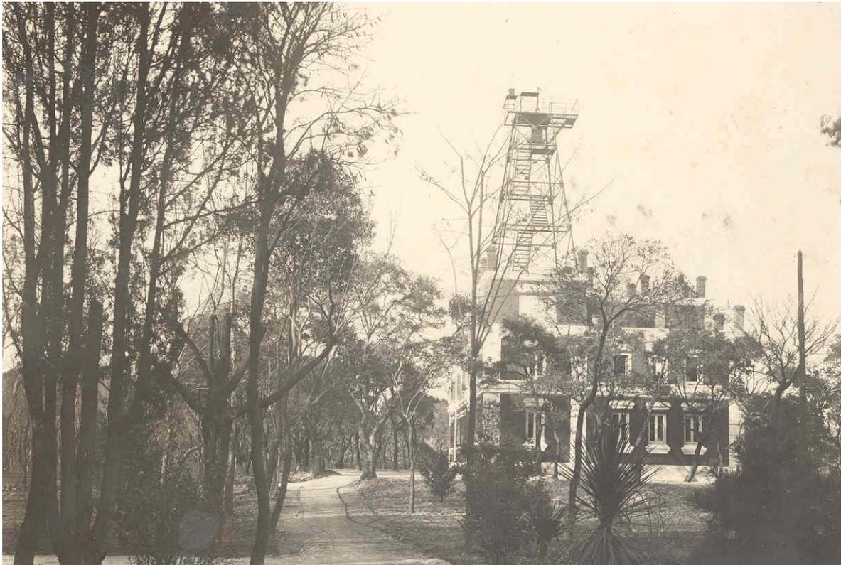
Figura 2. El edificio de 1913 poco después de su construcción, con una enorme estructura metálica para la instalación de anemómetros y el lanzamiento y seguimiento de globos con teodolito
