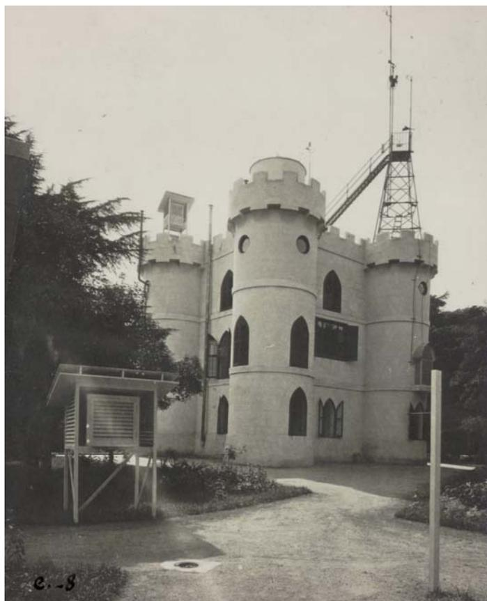
Figura 1. "El Castillo" en una imagen de principio del siglo XX. Puede verse la torre metálica para medición de viento y una de las garitas de observación en primer plano (se distingue otra en una de las torres).
