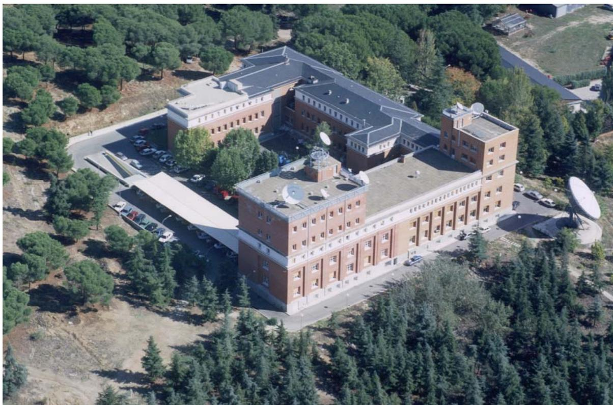
*Figura 8. Vista aérea actual del edificio de la Ciudad Universitaria. El ala con las dos torres corresponde a las dos ampliaciones posteriores a la construcción. Además se retiró parte del tejado de pizarra en el ala norte para disponer de otra terraza para instrumentación. La gran antena exterior data de los años ochenta.*
