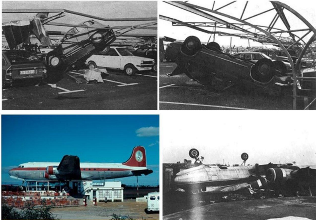
Destrozos en el aeropuerto de Sevilla al paso del tornado que lo atravesó el 27 de diciembre de 1978.
