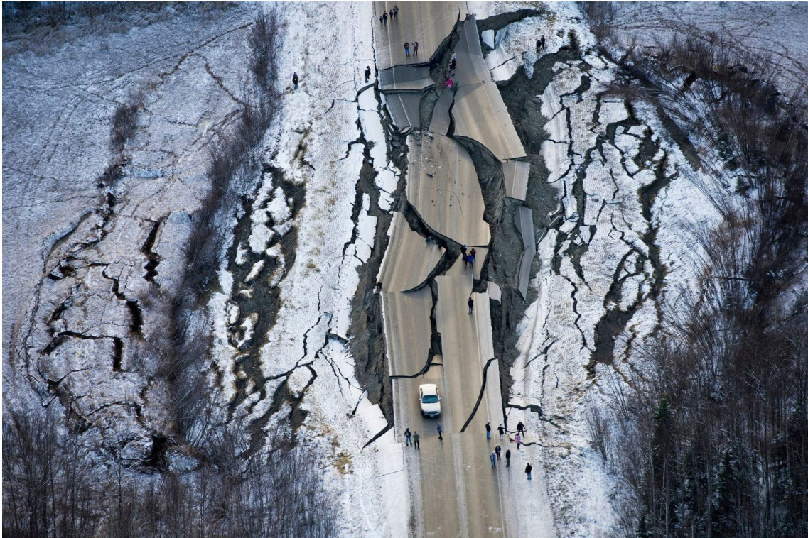
Espectacular fotografía aérea que muestra los daños causados en una carretera que discurre al sur de Wasilla, en Alaska, tras el terremoto que ocurrió el 30 de noviembre de 2018. Fotografía de Marc Lester /Anchorage Daily News. Crédito: AP.
