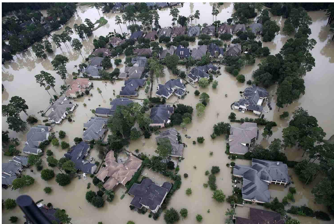
Barrio residencial de Houston (Texas) inundado al paso del huracán Harvey a finales de agosto de 2017. La ciudad texana sufrió en algunas áreas como la de la fotografía inundaciones catastróficas debidas a la acumulación de grandes cantidades de lluvia. Fotografía de Win McNamee. © Getty Images.
