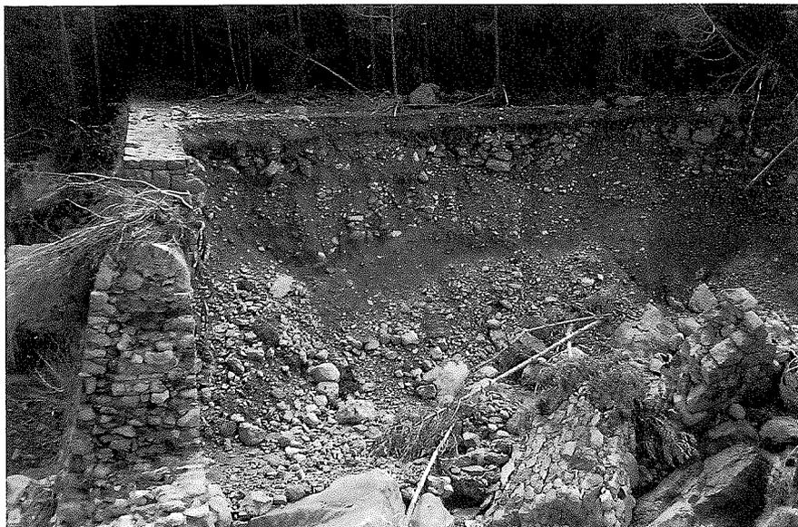
Foto 9. Pequeño resto de sedimentos acumulados aguas arriba de una presa rota y vaciada. El nivel superior de los sedimentos enrasa con el borde de la presa. (Foto: García Ruiz).
