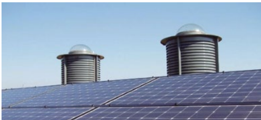
Fig. 4.2.8. Torres de viento instaladas (Monodraught)
