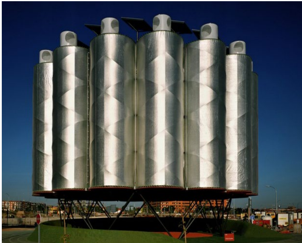
Fig. 4.1.7. Árbol Sur Ensanche de Vallecas antes de su retirada
