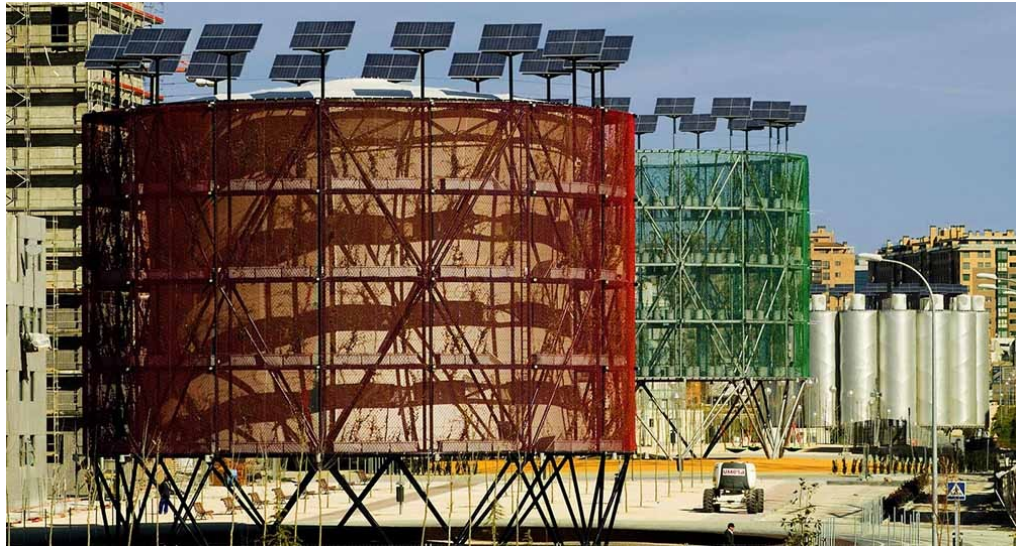
Fig. 4.1.6. Ensanche de Vallecas antes de la retirada de los “Árboles de Aire”
