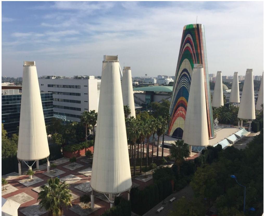
Fig. 4.1.2. Torres de viento en Avenida de Europa, Expo Sevilla 92' (autor desconocido)
