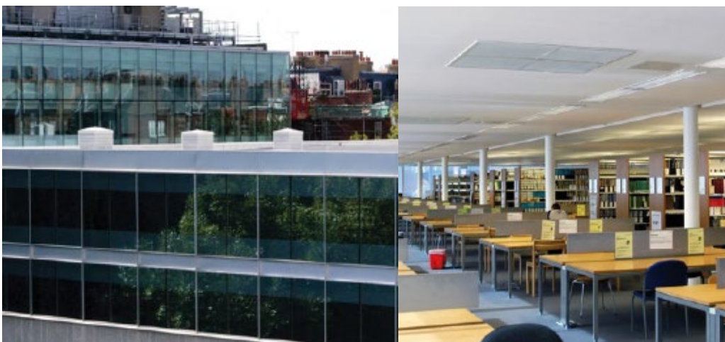
Fig. 4.2.14. Torres de viento sobre biblioteca (interior y exterior) (Monodraugh)
