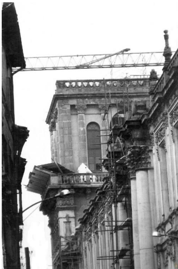
Figura 16.- Derribo de la torre y fachada de la Universidad, 1968-1969.
