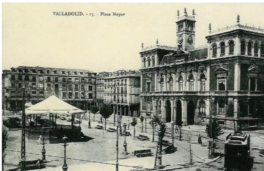
Figura 4.- Torreón de la Casa Consistorial, donde se instaló el Observatorio entre los años 1909 y 1916.
