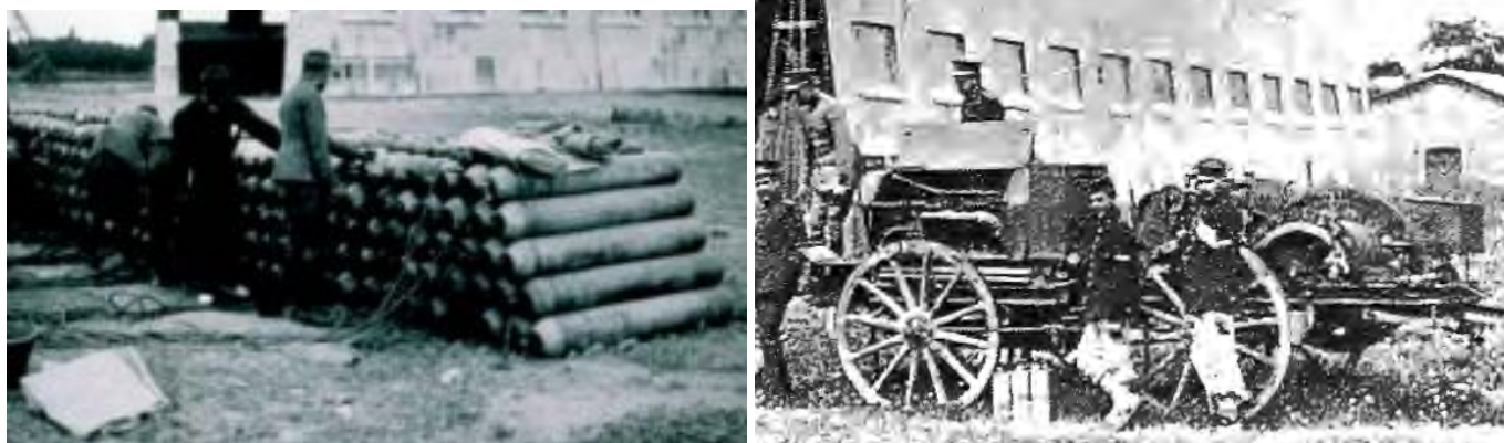
Fig.18. Apilamiento de cilindros de hidrógeno para inflación de un globo (Foto: Goñi, Agrupación Fotográfica de Guadalajara, AHP). Fig. 19. Foto del tren modelo YON, de producción de hidrógeno de la Servicio de Aerostación Militar de Guadalajara. Ibérica: el progreso de las ciencias y de sus aplicaciones: Revista Semanal Ilustrada . Nº 21, del 23 mayo 1914.
