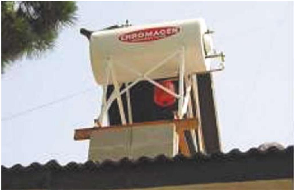
Figura 7. Instalación para suministro de agua caliente sanitaria con energía solar térmica mediante equipo compacto termosifónico.
