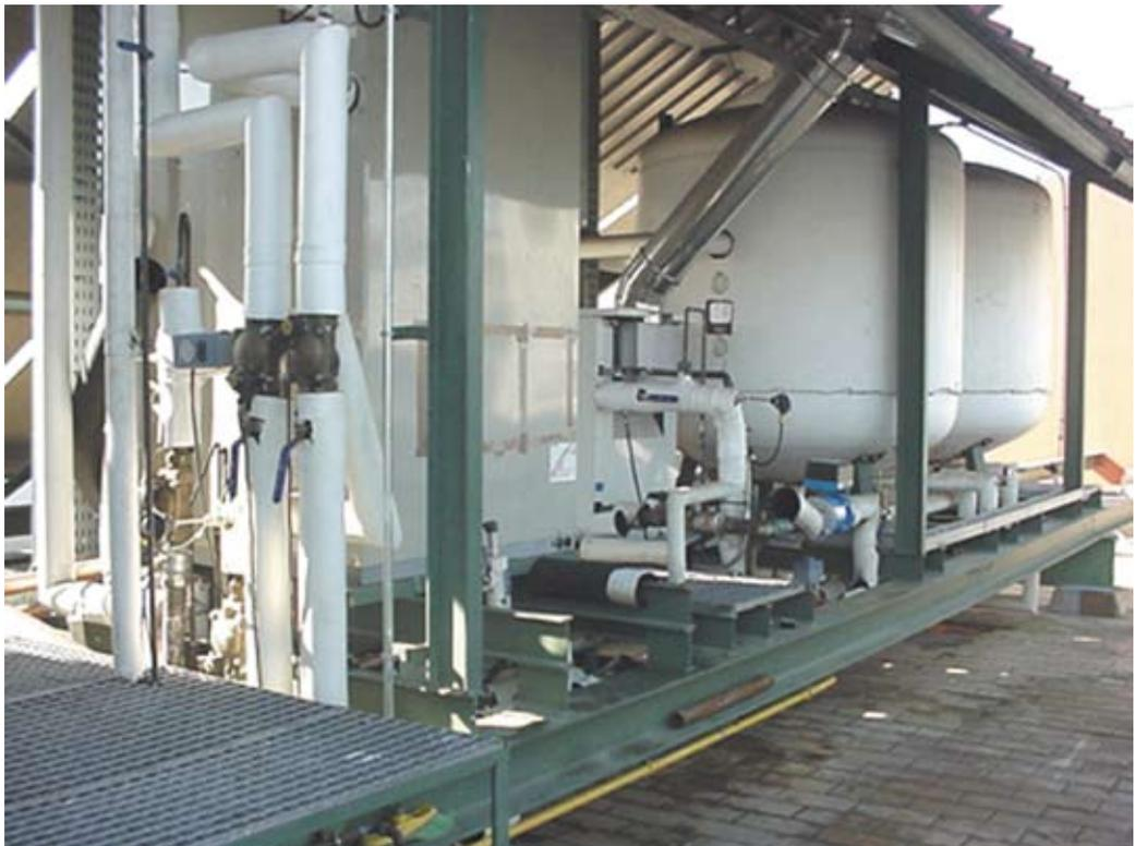
Figura 18. Instalación de climatización solar con máquina de absorción
