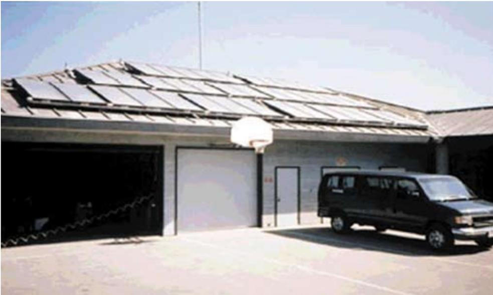
Figura 9. Sistema forzado para agua caliente sanitaria.
