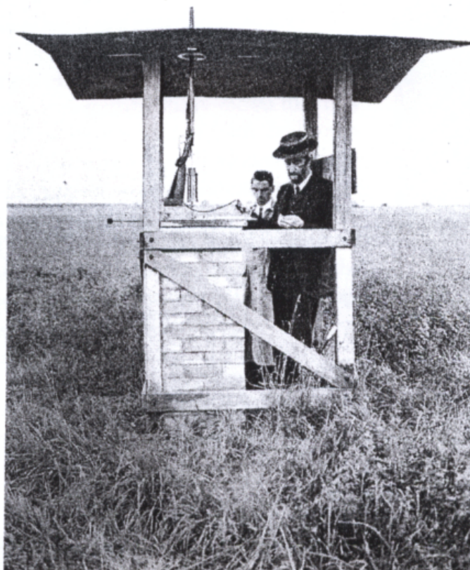
Figura 4.- Observadores del tiempo en los años 20 bajo un tejado metálico midiendo el viento de forma experimental en el observatorio de Benson. Nótese la escopeta en la figura. Fuente: Heasman (2006).
