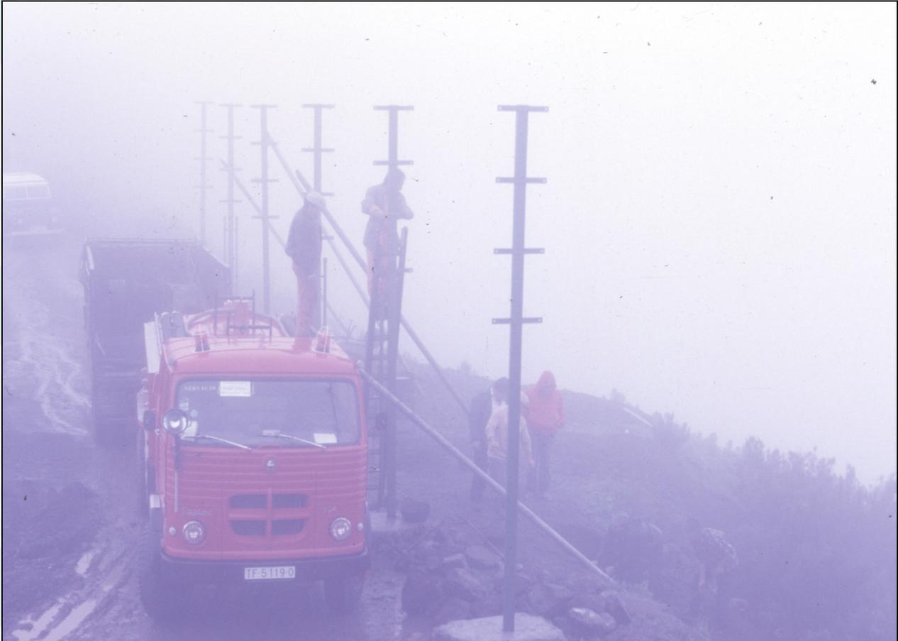
Detalles de las dimensiones e instalación de las estructuras metálicas. En la instalación del captaniebla se utilizaron todos los medios disponibles por el ICONA de La Palma en una difícil orografía y condiciones atmosféricas adversas e idóneas para la recogida de **precipitación de niebla**: ambiente ventoso y muy húmedo.
