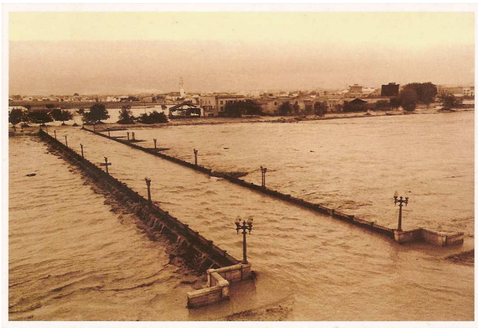
Fig. 13: Imagen del puente de Campanar sobre el río Turia la mañana del 14 de Octubre. Al fondo Campanar. Foto: Francisco Pérez Aparisi.
