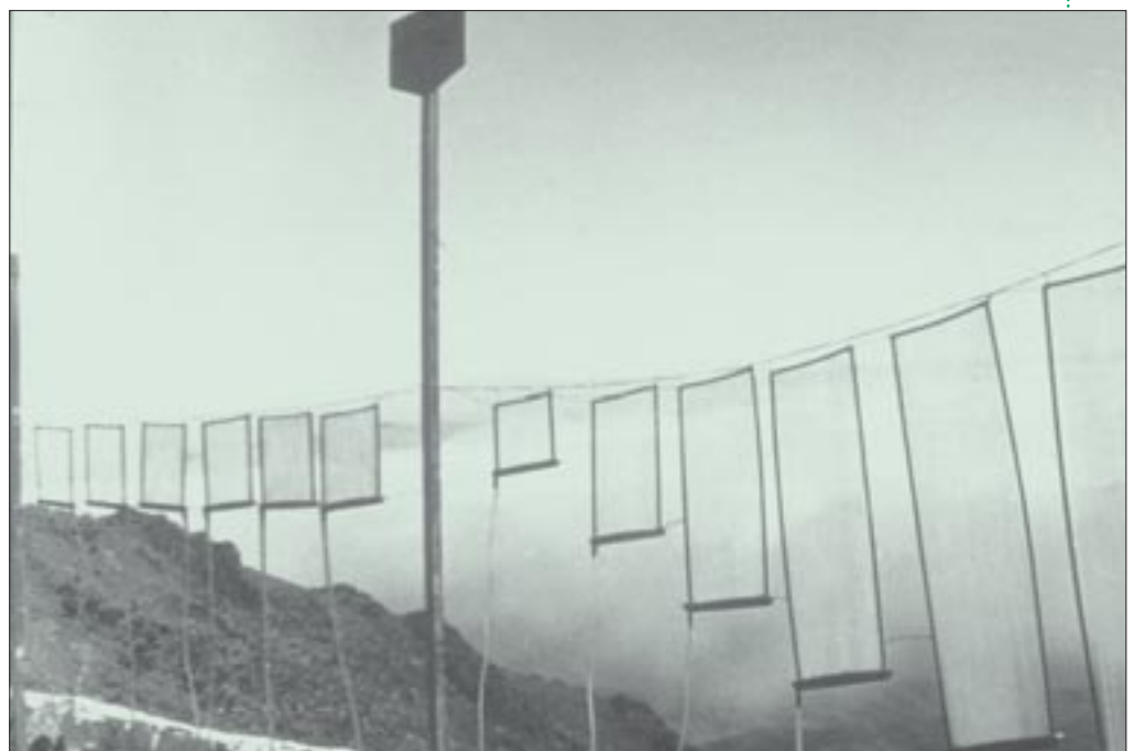
Foto 4.- Atrapanieblas y conducción para abastecer con agua potable a la población de Chungungo (año 1990, desierto de Atacama, Chile)
