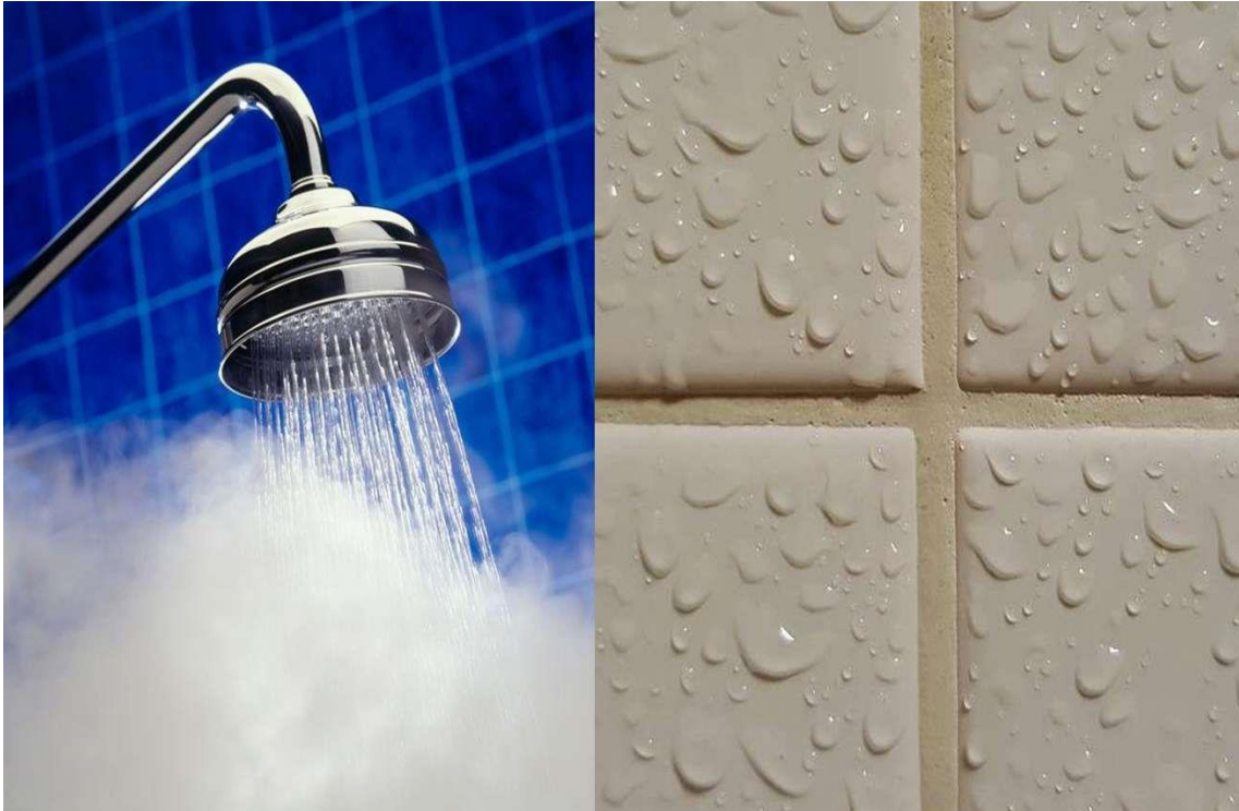
Izquierda: Ducha abierta generando el mal llamado vapor, pues esa niebla está formada por gotitas de agua microscópicas. Derecha: Condensación de agua en las baldosas de un baño
